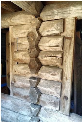
Mellanväggen är timrad
