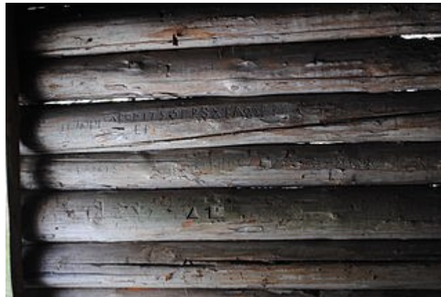
Många välgjorda ristningar. Det äldsta årtalet 1750 är jämgammalt med ladan
